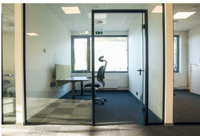
Fra det 300 kvadratmeter store kontorområdet i andre etasje mot vest i bygget. Her ser vi er teppflis på gulv, systemglassvegger, stendervegger med malt gips på overflater, og systemhimling.
