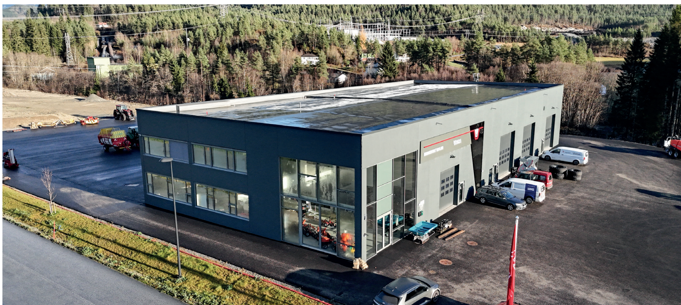
Det nye bygget i Moøyane 1 inneholder butikk, kontorer, lager, verksted og vaskehall. Her sett fra sørvestlige hjørne med butikk på bakkeplan og kontor i andre etasje nærmest til venstre.
